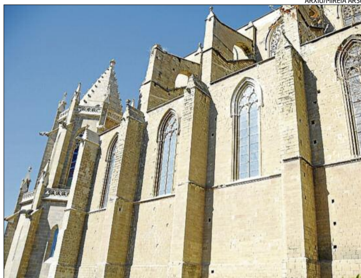
Els dos contraforts que restauraran són els del mig de la fotografia
