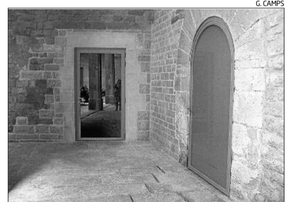
Les portes s'han posat noves i s'ha restaurat la pedra
