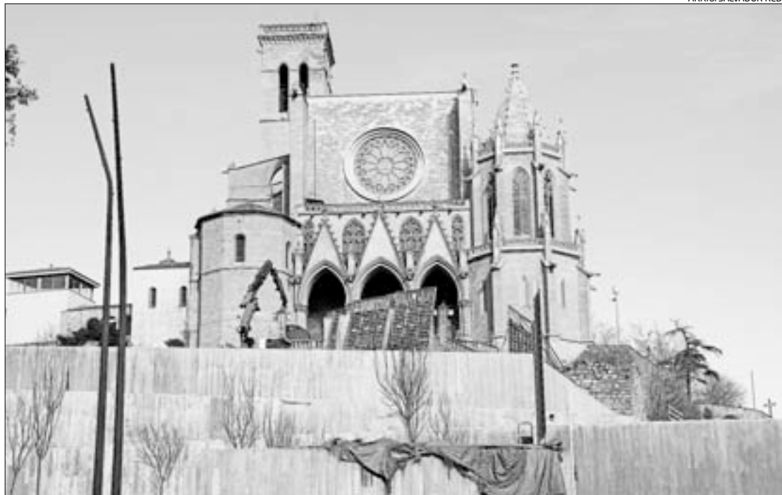
La part de les obres a la Reforma que ha desfermat la polèmica: un mur que tapa una part de la portalada
